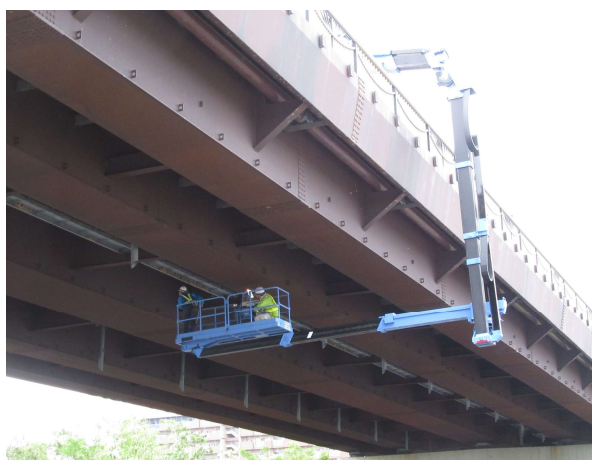
現地点検風景（大型橋梁点検車）
