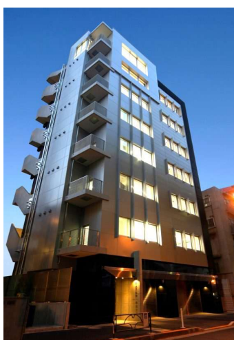
本社外観（8階建ての自社ビルです）
