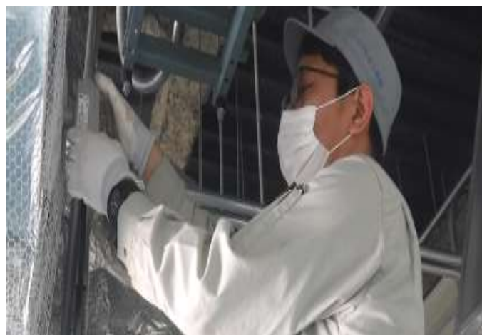
現場での作業の様子
